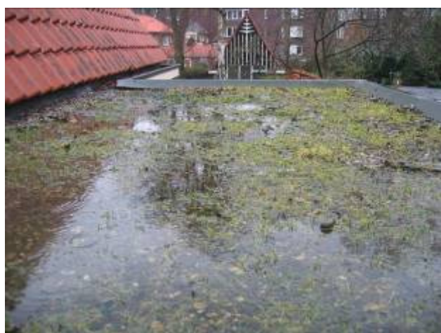
Bitumenbedekking platte dak zuidwesthoek.
