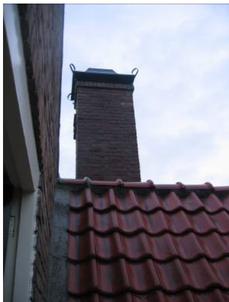
Aansluiting dak uitbouw, opgaande gevel.
