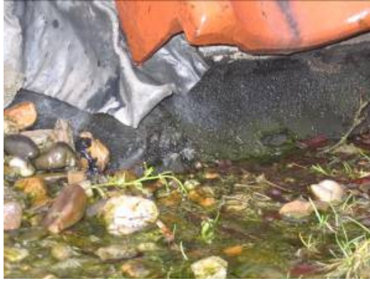
Hoekdetail aansluiting loodwerk en opstaande kant bitumen.
