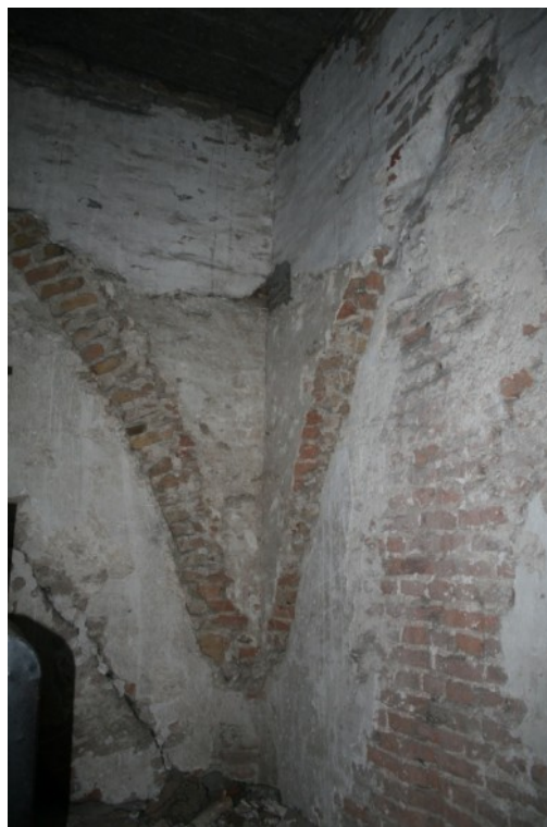
Afb 5 Gewelfaanzetten torenportaal foto J.L.C. Weyts
